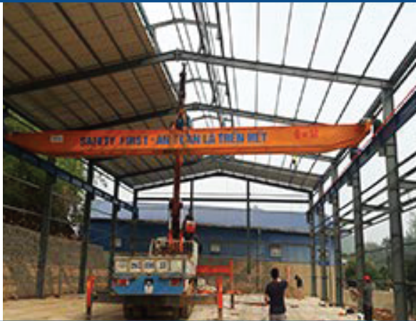
Thi công cầu trục Công ty TNHH Thép Sơn La
